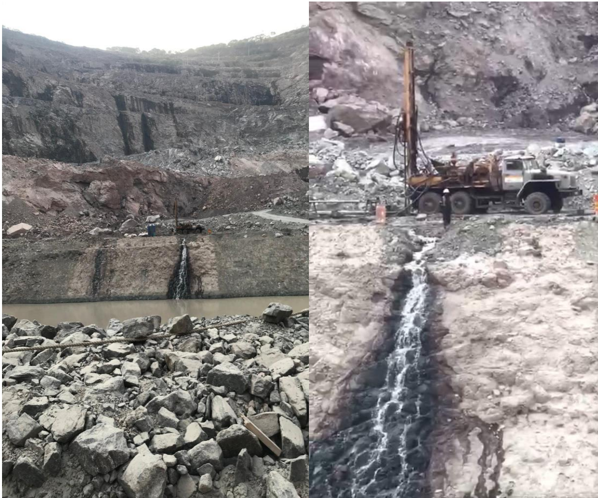
Figura 3.2.13 - Manchas de água na cava
